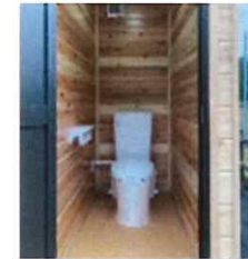
災害用トイレの整備
